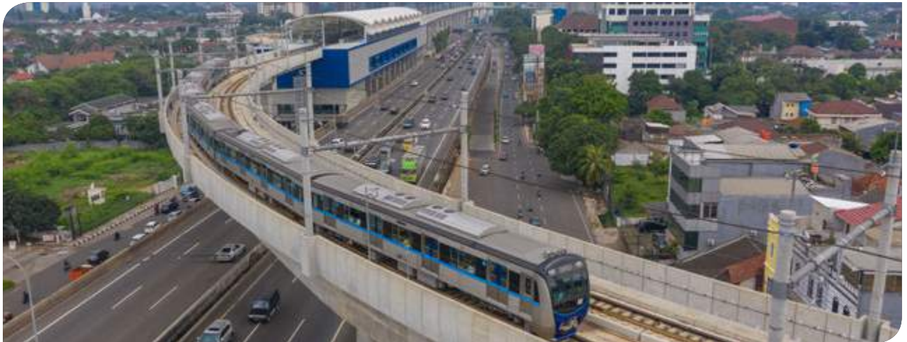
Gambar 1.8. Sarana MRT Jakarta melintasi jalur layang dari Stasiun Fatmawati menuju Stasiun Cipete Raya Image 1.8. MRT Jakarta rolling stock running along elevated track from Fatmawati Station towards Cipete Raya Station
