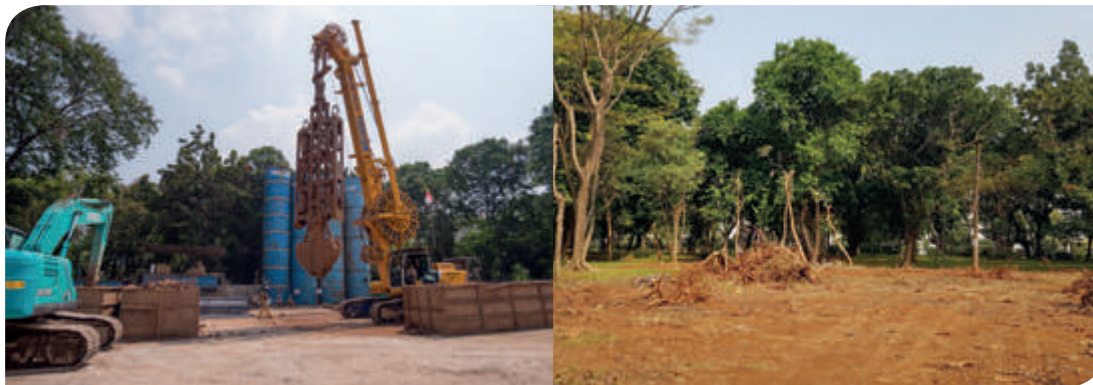
Gambar 7.4. Pembersihan Area Setelah Konstruksi dan Penanaman Pohon Kembali Image 7.4. Clearing the Area after Construction and Replanting
