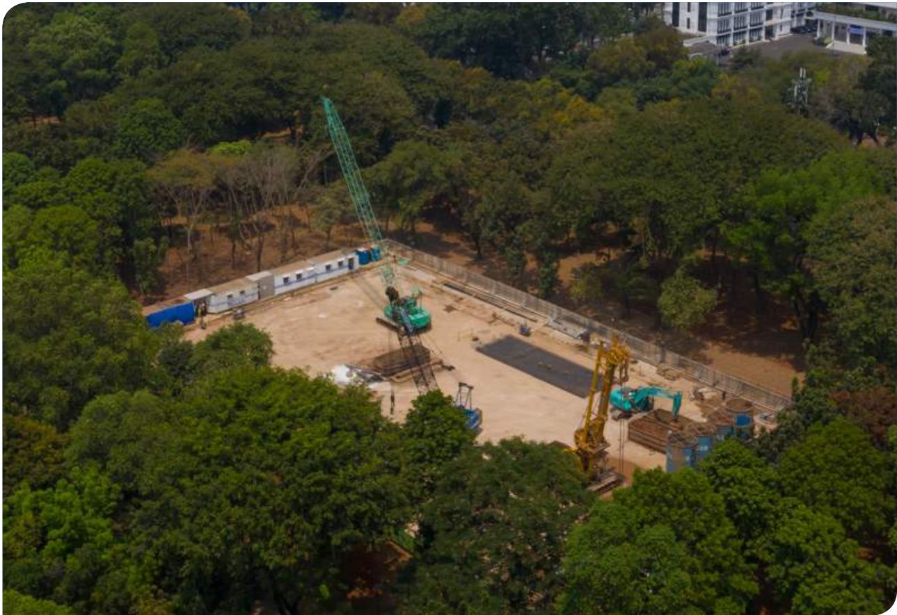
Gambar 1.11. Proyek Pembangunan Stasiun Monas Image 1.11. Monas Station Construction Project
