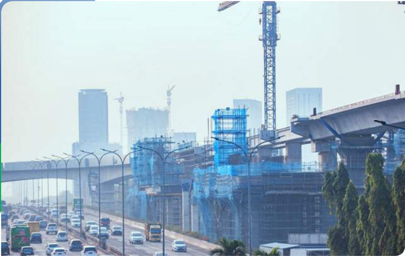
Gambar 1.2. Pengerjaan Konstruksi Fase 1 MRT Bundaran HI - Lebak Bulus Image 1.2. Construction Work of MRT Phase 1 Bundaran HI - Lebak Bulus
